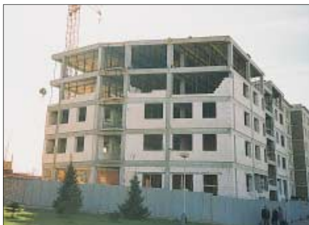
Bytový dům Praha 10
