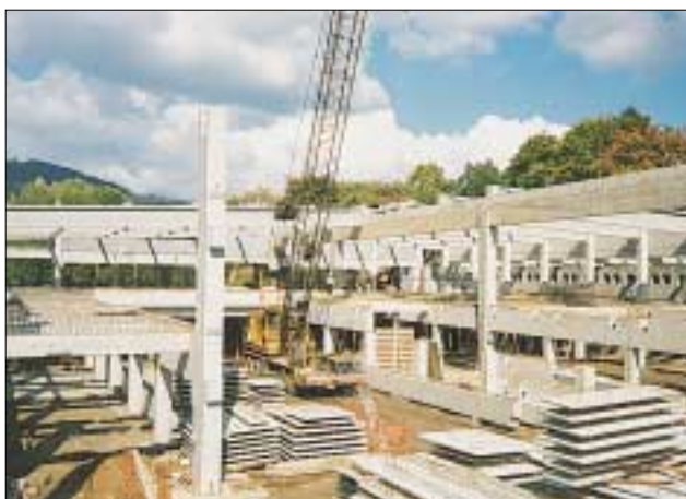
Dvoupodlažní výrobní hala Kraslice
